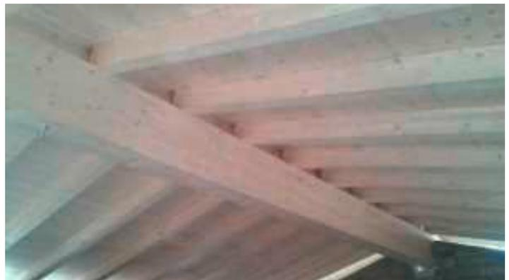
La copertura dell'autorimessa avrà una struttura in legno e/o acciaio, pannello grecato coibentato e manto di finitura in tegole portoghesi, come l'abitazione.
