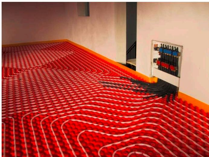
La rete di distribuzione dell'impianto idraulico è del tipo multistrato, con idoneo coibente. All'ingresso di ciascun bagno sarà realizzato un collettore per la distribuzione ai singoli punti, evitando così giunti di tubazione sotto pavimento.
